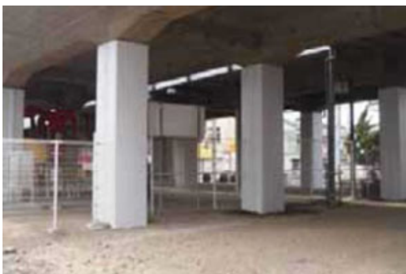
図 2-5 耐震補強の例（鋼板巻き補強） 2-8)
