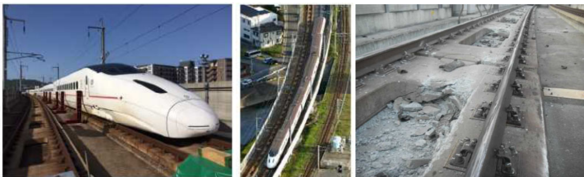
図 2-4 熊本地震における新幹線の脱線状況 2-7)
