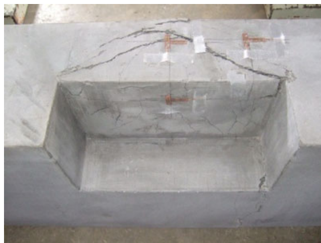
(b) 供試体 B2 (押し抜き破壊に似た損傷)
