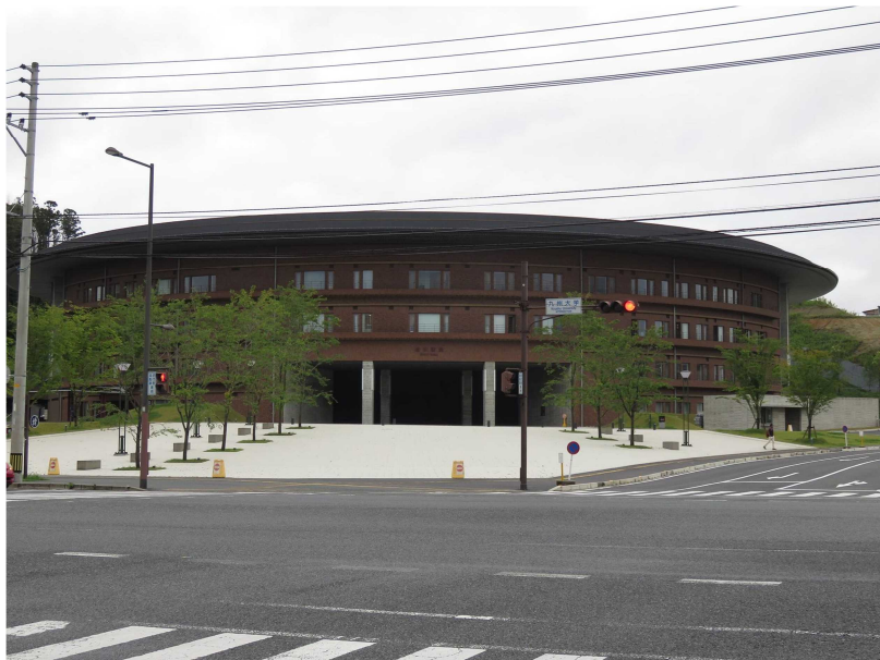
図 14-27 椎木講堂 (2014年竣工)
