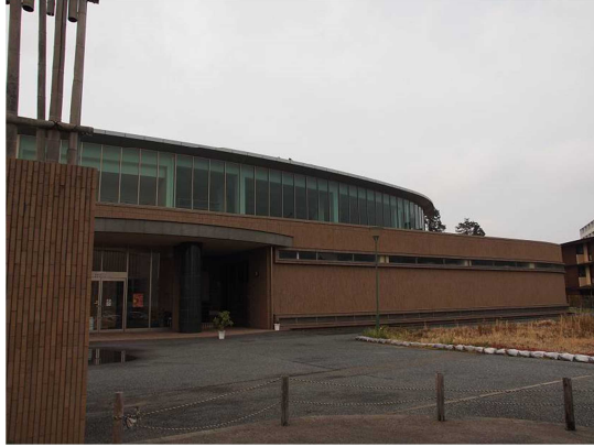
図 13-18 環境安全衛生推進室（環境安全センター・給水センター棟）
