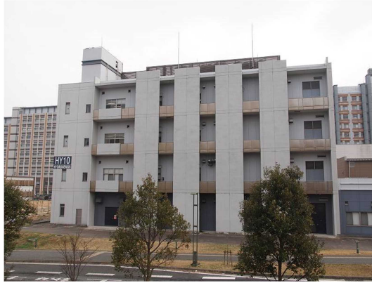
図 13-15 水素材料先端科学研究センター実験棟
