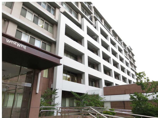
図 13-16 九州大学病院ウエストウイング棟 入院棟を改装した建物で、先端融合医療創成センターが入居している。
