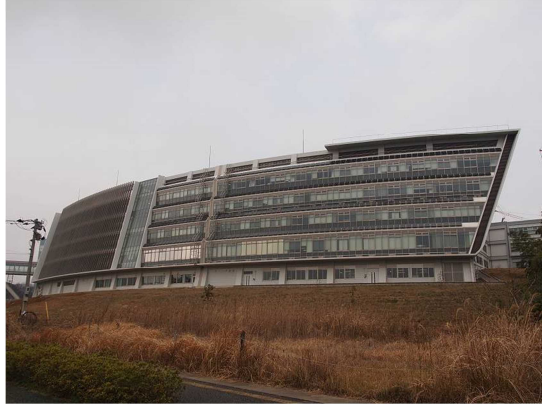
図 13-17 次世代燃料電池産学連携研究センター棟 （写真右側）
