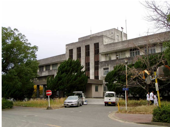
図 12-21 医学部基礎研究 B 棟（改修前）
