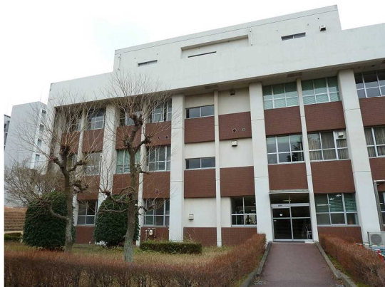
図 12-20 筑紫地区事務棟
