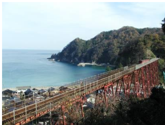
図 2-1 対象橋梁の概要（海側が北方向）
