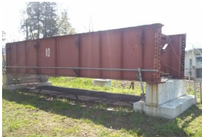
図 3-9 切り出し部材の外観
