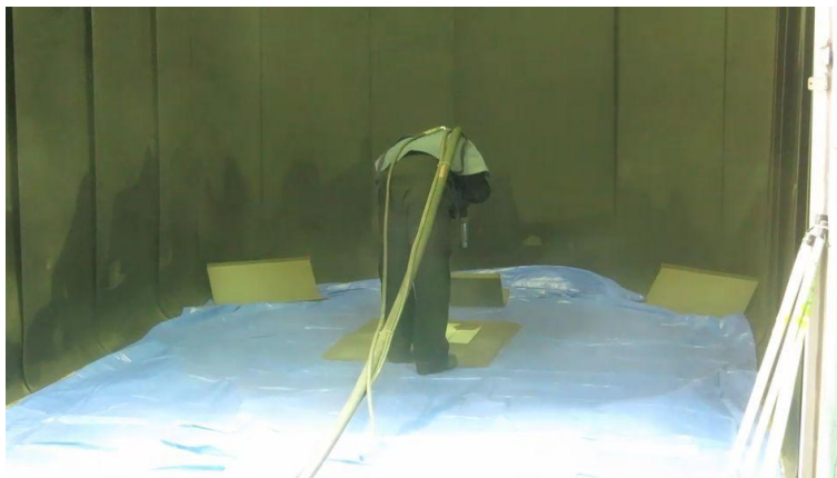
図 5-3 ブラスト時の作業状況
