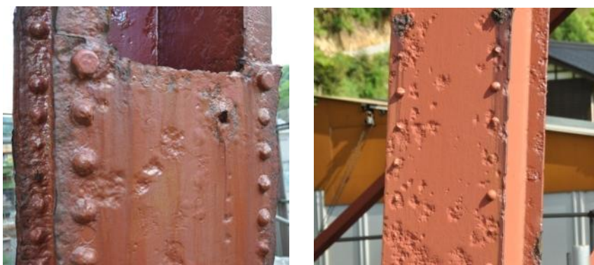
図 2-5 3号橋脚主構部の外観
