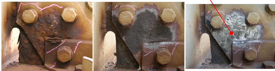
固着した腐食生成物以外を 除去した際の状態
