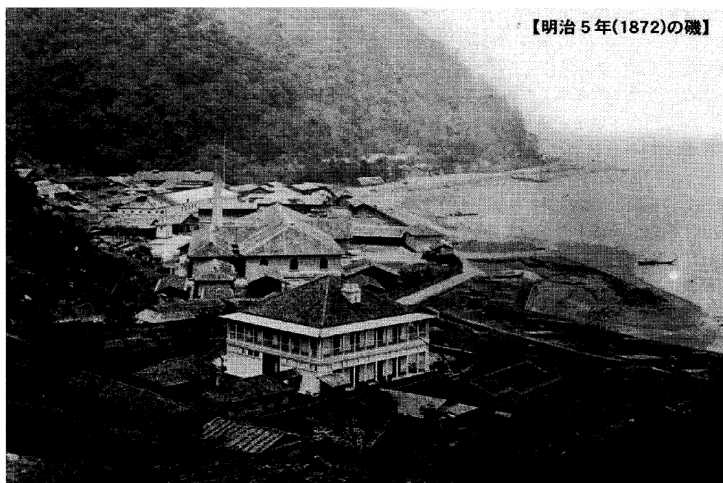
図3 後期の集成館と鹿児島紡績所技師館（手前）：1872（明治5）年
