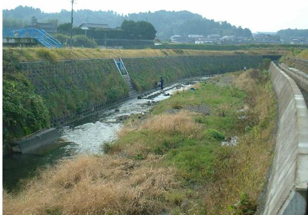
Photo.1-5 土砂の堆積した例
