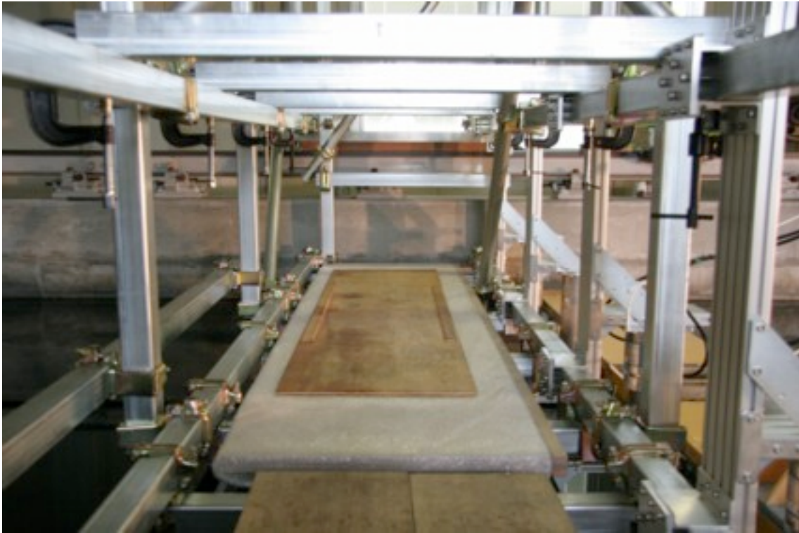
図13 係留作業スペース
