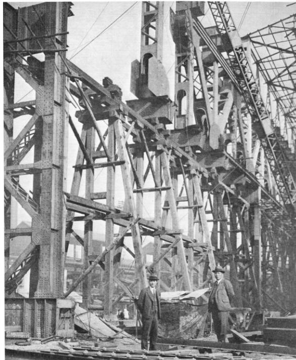
写真7-1 新一製鋼工場ガントリークレーンガーダー架設時写真（八幡製鐵所土木誌より掲載）
