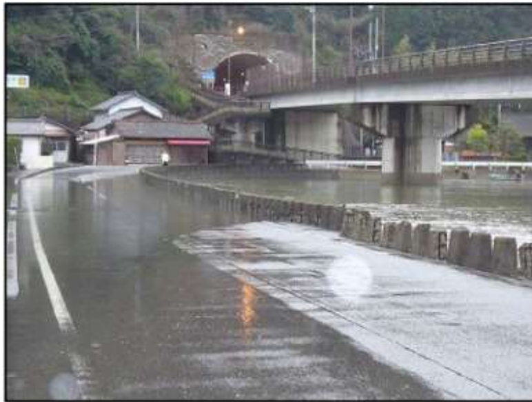
熊本県天草下島崎津地区での道路冠水の様子 (写真提供 天草市役所河浦支所)
