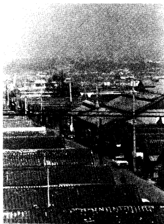
⑤ 三井伊田坑跡、三坑銀座
